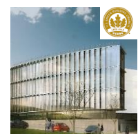
Avenida de Bruselas
