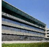
16 COMPLEJO DE SANT OFICINAS CUGAT NORD
