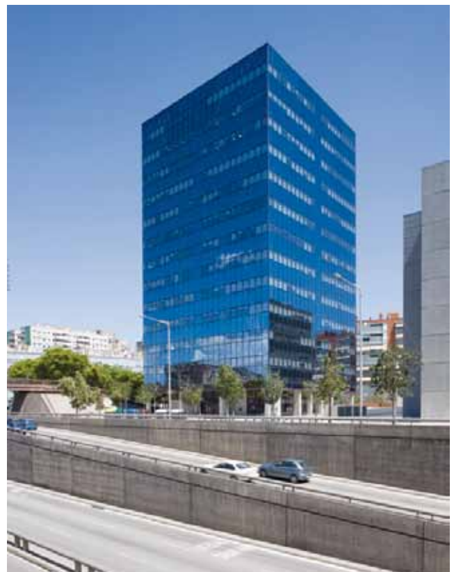
TORRE BARCELONA, BARCELONA
