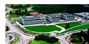
Complejo oficinas- Sant Cugat
